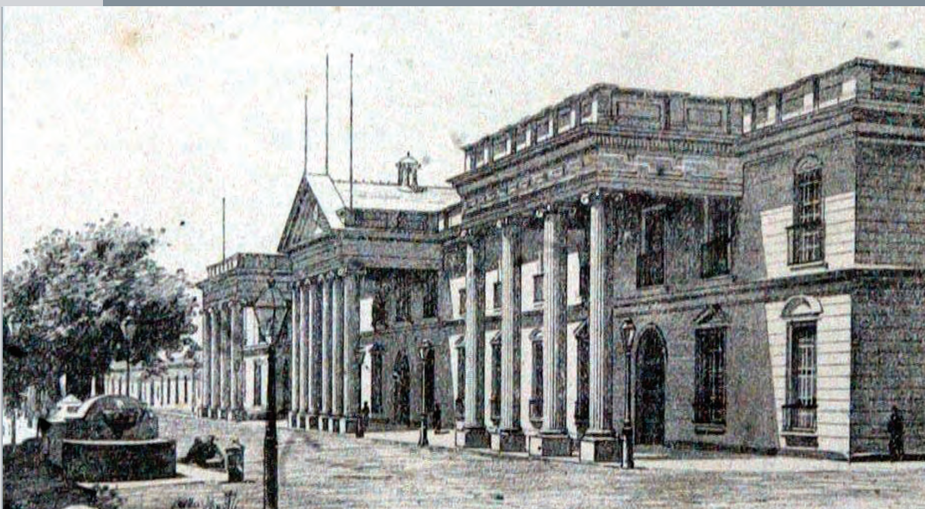
Fachada del primer Palacio Nacional de El Salvador, con sus tres juegos de columnas. Enfrente, en la polvorienta Plaza de Santo Domingo (ahora Parque Barrios o Plaza Cívica) puede verse una de las 21 pilas públicas para abastecimiento de agua que poseía la ciudad en la segunda mitad del siglo XIX.
